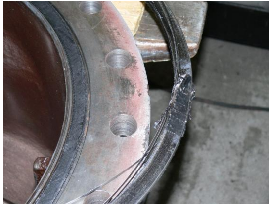
Bild 2: Sicherung von Spiraldichtungen mit Klebeband
