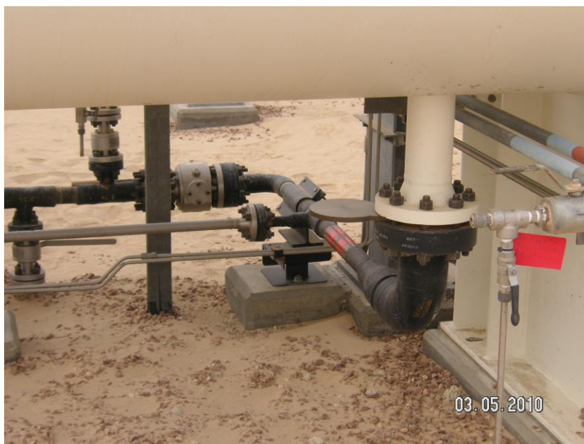
Abb.1: Kunststoffflanschverbindungen
