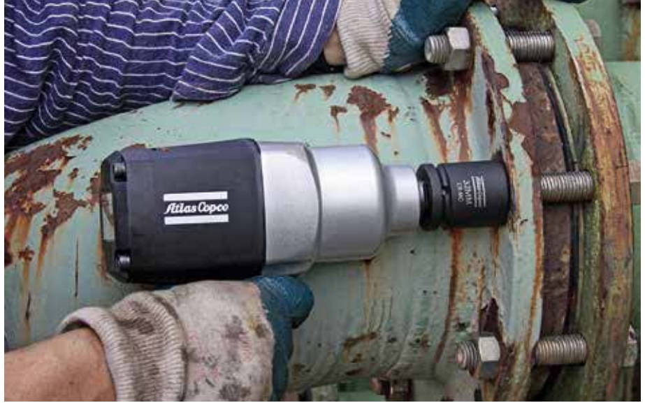
»1 In der Praxis wird bei Flanschverbindungen häufig der Schlagschrauber eingesetzt. Wichtig ist hier ein anschließendes Prüfen der Verbindung mit einem Drehmomentschlüssel
